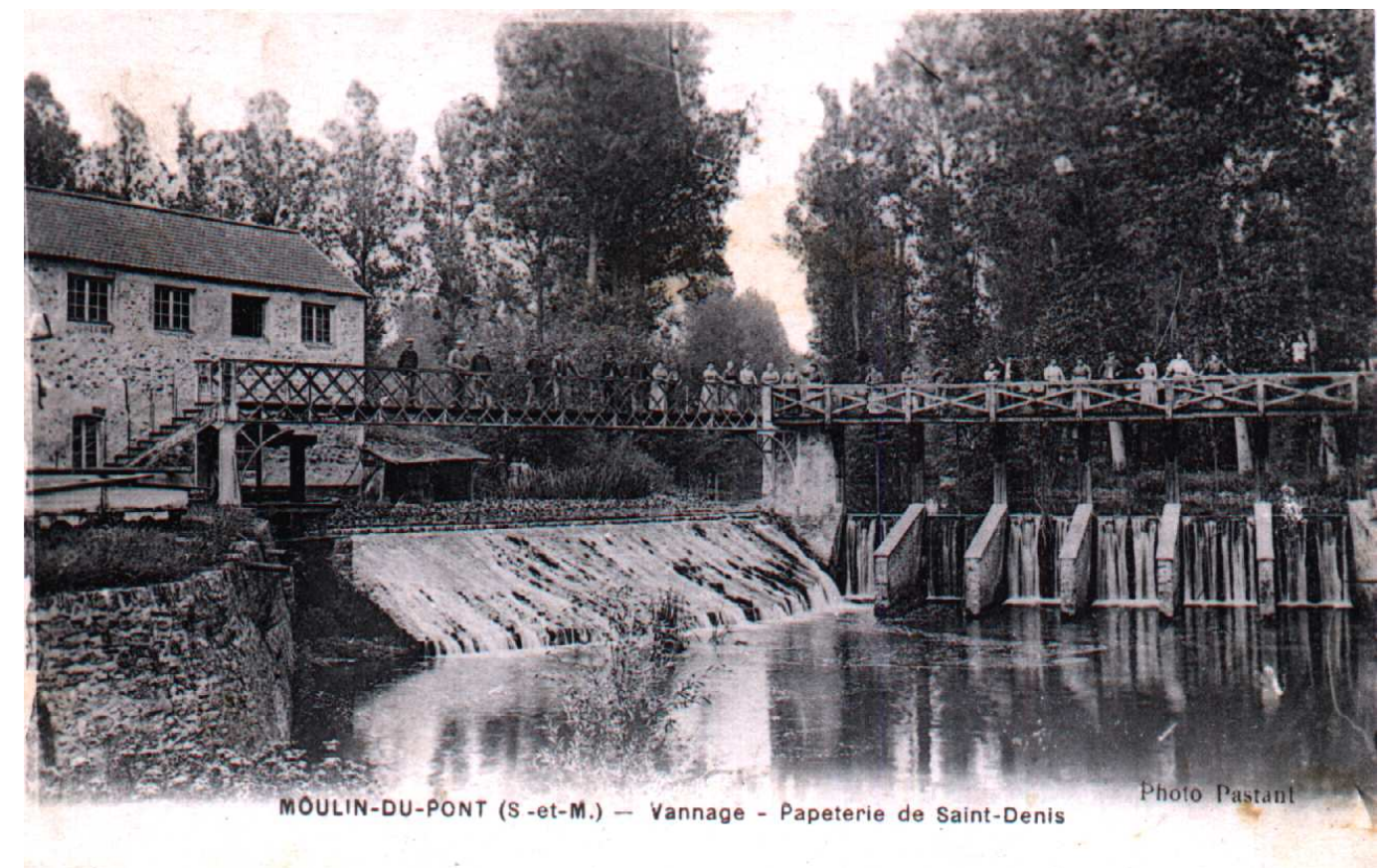
Ouvrage hydraulique de la Fontaine (Saint Rémy de la Vanne) – Usine de Saint Denis (1900 – 1950)
