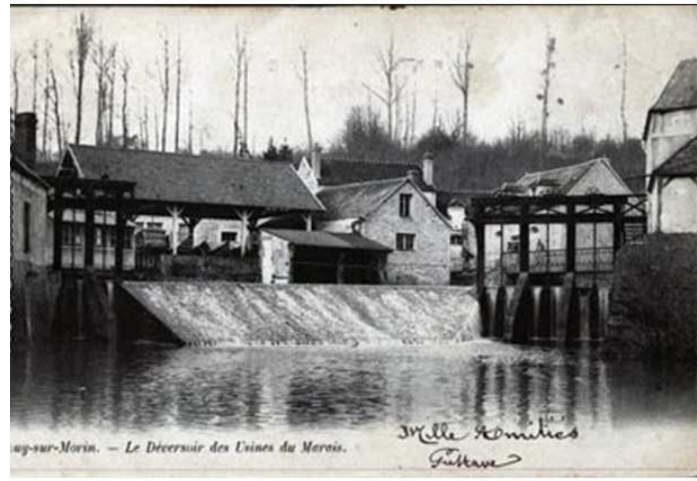
Hameau du Marais (Jouy sur Morin) – Vannage de la papeterie du Marais (1900 – 1950)
